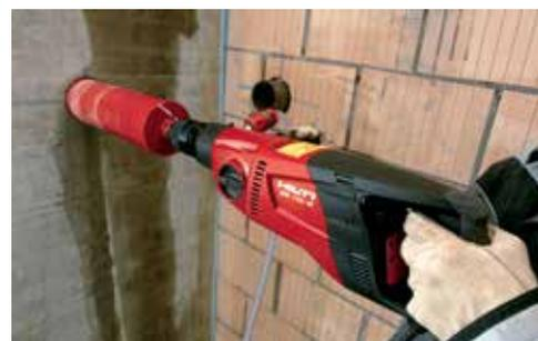
**Applications :** Forage de traversées pour conduites de chauffage, sanitaires et de climatisation.
