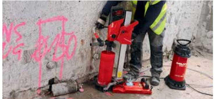
Hilti recommande toujours de forer à l'eau dans le **béton armé ou non armé**.
