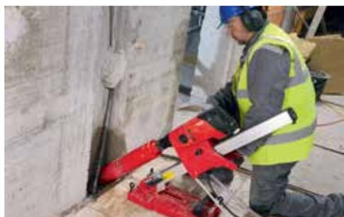
**Applications :** Forage à l'eau, réalisations de traversées et d'ouvertures dans le béton. Installation de mains-courantes et clôtures. Fixation de mobilier urbain
