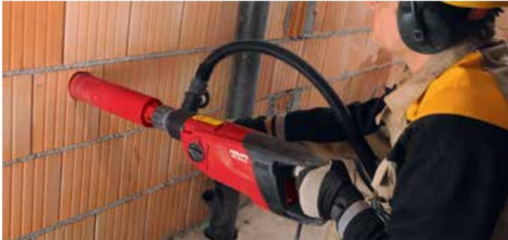
Hilti recommande de forer à sec dans la **maçonnerie / pierre** en utilisant un aspirateur.
