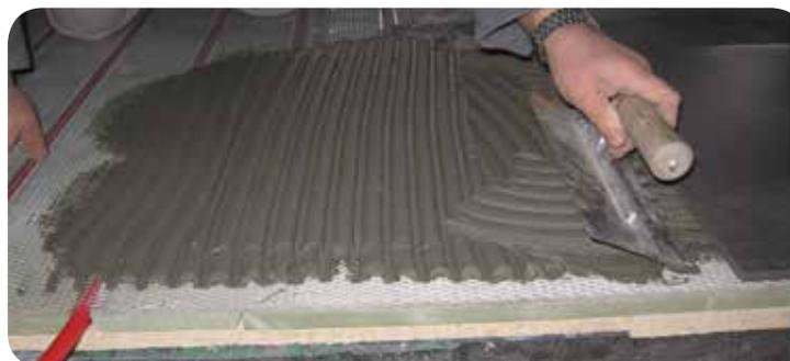
Exemple de pose directe de carrelage sur l'émetteur avec du mortier-colle flexible.
