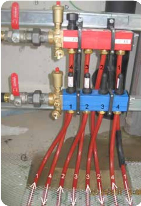
Comme illustré par la photo ci-contre, lorsque plusieurs tuyaux en parallèle alimentent une même zone thermique, leurs extrémités sont raccordées au collecteur en alternant les départs et les retours et en imbriquant les tuyaux.
