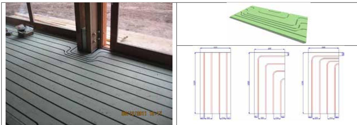
Selon la nature du support, les panneaux pourront être fixés grâce à des vis, des agrafes ou de la colle. Il sera également possible de laisser les panneaux entièrement flottants sur le support.
